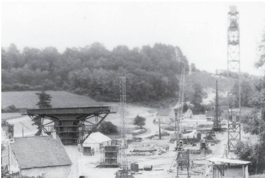
Travaux du viaduc autoroutier.
